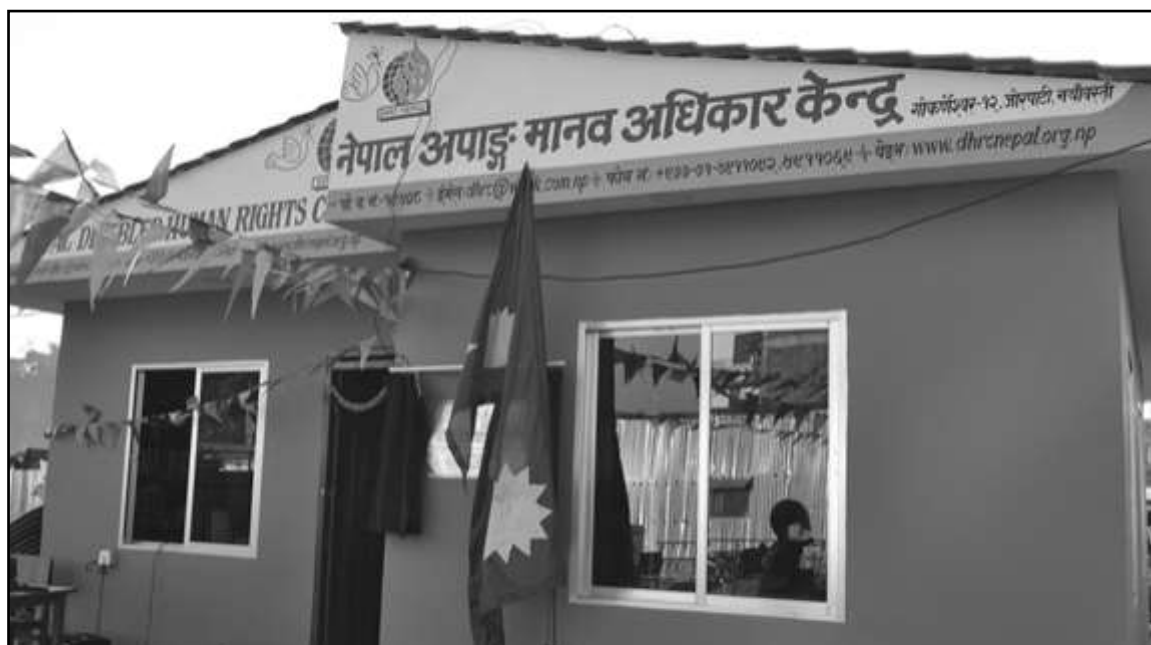
नेपाल अपाङ्ग अधिकार केन्द्रको अपाङ्गता मैत्री सूचना तथा स्रोत केन्द्रको नवनिर्मित भवन । तस्विर : शर्मिला विश्वकर्मा
